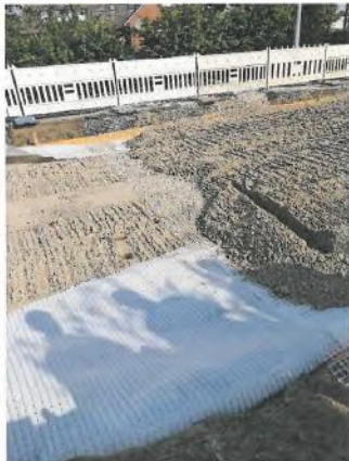
Beginn der Herstellung des geotextil bewehrten Unterbaus.
