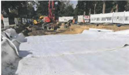
Beginn der Herstellung des geotextil bewehrten Unterbaus.
