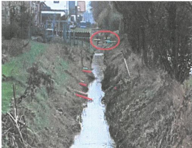
Bild: Drainagerohre Grundstücke am Findorffhof (von Jutta Kemmer)
