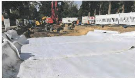
Beginn der Herstellung des geotextil bewehrten Unterbaus.
