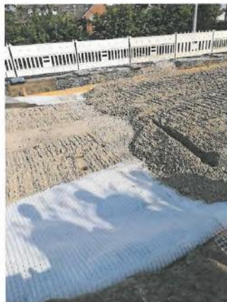
Beginn der Herstellung des geotextil bewehrten Unterbaus.
