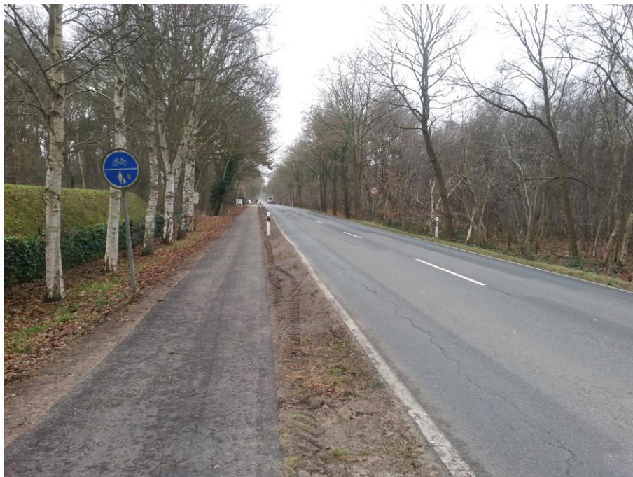
Rautendorfer Landstraße, Blickrichtung derzeitige Anbindung Garten- und Landschaftsbaubetrieb
